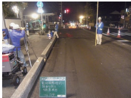
路面切削厚確認
