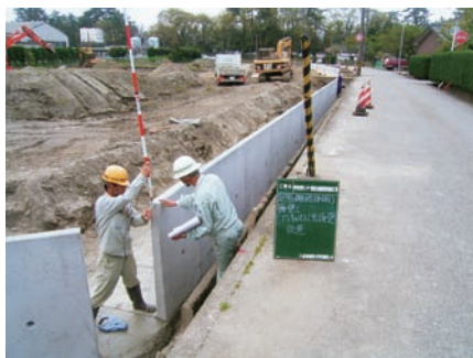
擁壁工延長確認
