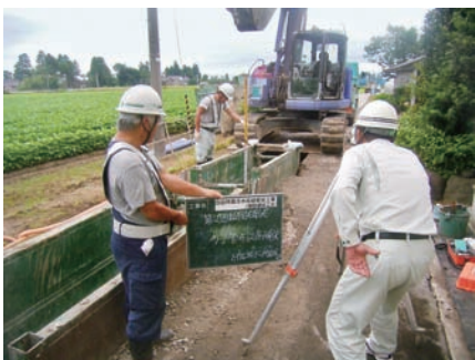
管渠布設高確認
