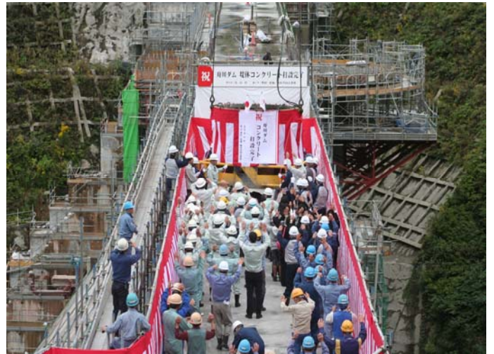
舟川ダム 堤体コンクリート打設完了 H22. 10. 22
