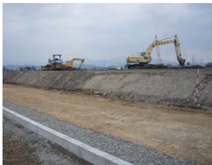
土砂搬入状況
