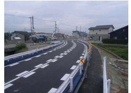
県道迂回路の状況
