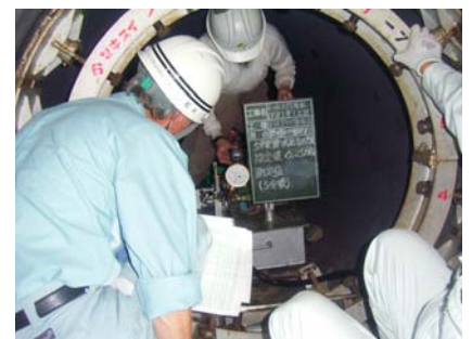
水圧管継手部の漏水試験確認
