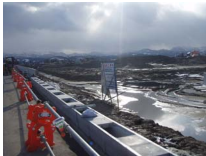
道路排水路工
