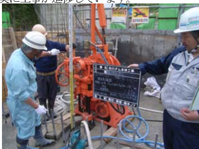
グラウチング段階確認
