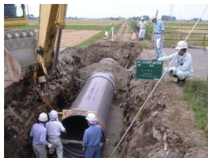
水圧管敷設状況
