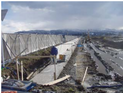
L型擁壁工
