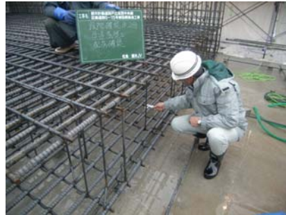
管渠鉄筋組立 段階確認
