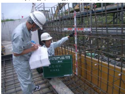
沈砂池配筋段階確認
