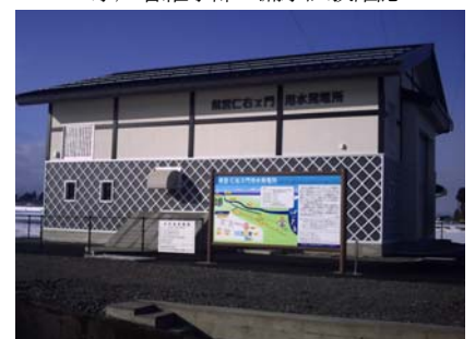
完成した仁右工門用水発電所
