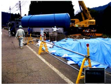
クレーンによる防火水槽吊上げ
