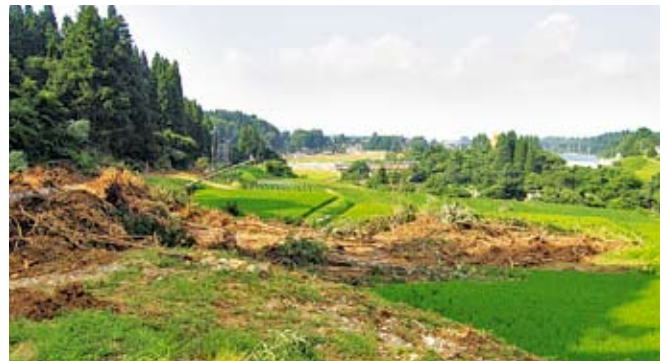
南砺市農地災害の現場(当センターが復旧事業一部受託) H20.7.28被災
