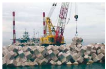
⑥ [ブロック据付状況]
