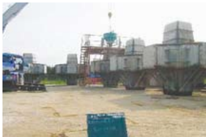
① [50tブロック製作状況]
