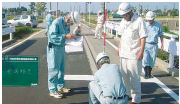
[現場検査実施状況]
