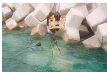
⑤ [ブロック水中据付状況]
