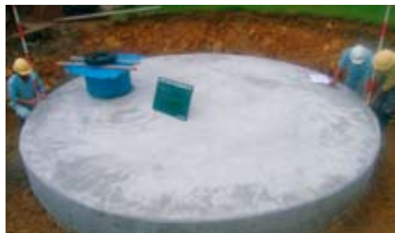
防火水槽 頂版コンクリート出来形確認
