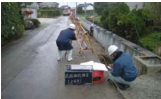
自由勾配側溝基準高確認
