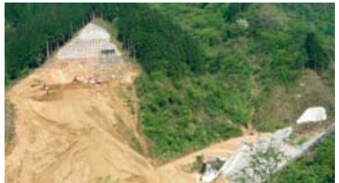
舟川ダム本体工事(当センターが一部施工管理) H20.4.28撮影
