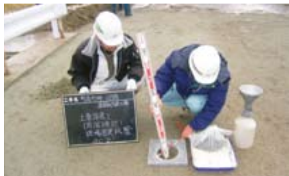
上層路盤現場密度試験立会い
