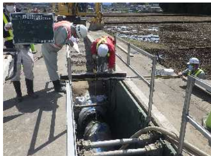
管路布設状況 確認 西部工業用水道事業 管路更新 工事 発注者：富山県企業局 〔施工管理〕
