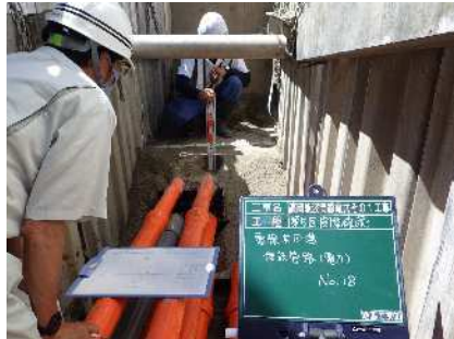
管路布設状況 確認 (都) 高岡駅波岡線 電線共同溝 工事 発注者：富山県高岡土木センター 〔施工管理〕
