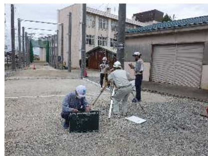
クレー舗装下層工基準高 確認 富山県立入善高校 アーチー場整備 工事 発注者：富山県教育委員会 〔設計積算・施工管理〕
