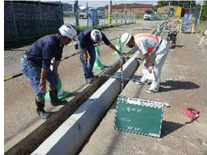
消雪ブロック布設状況 確認 (一) 浅地小矢部線 消雪工 (リフレッシュ) 工事 発注者：富山県砺波土木センター小矢部土木事務所 〔施工管理〕
