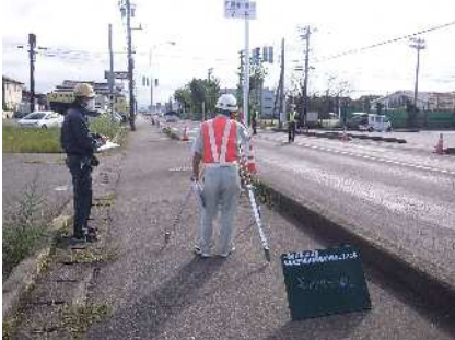
路面切削工基準高 確認 県管理道路 舗装補修 工事 発注者：富山県富山土木センター 〔設計積算・施工管理〕
