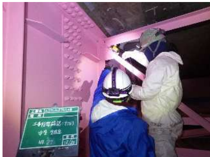
塗装塗膜厚 確認 白岩橋 橋梁補修 工事 発注者：立山町 〔設計積算・施工管理〕
